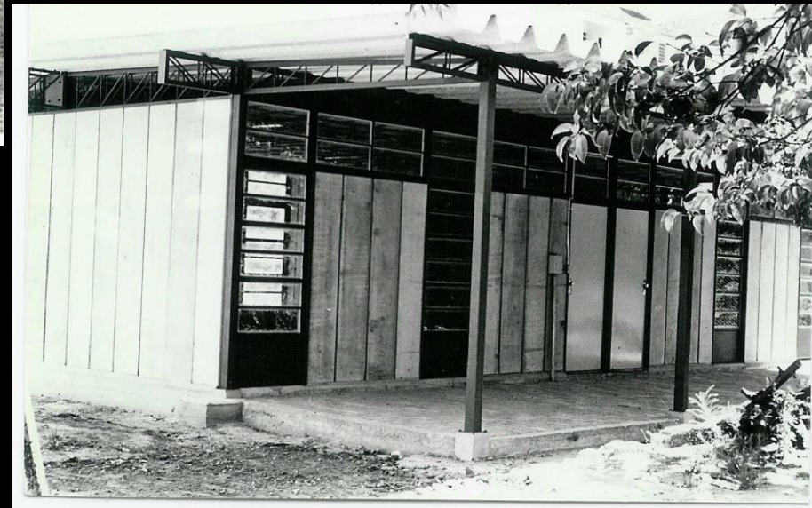
Escola Emergencial em Argamassa Armada
