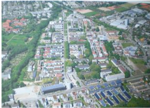
Vauban, Germany- Vista aérea
